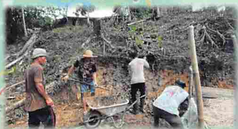
土手を削って、土を動かすのも手作業
